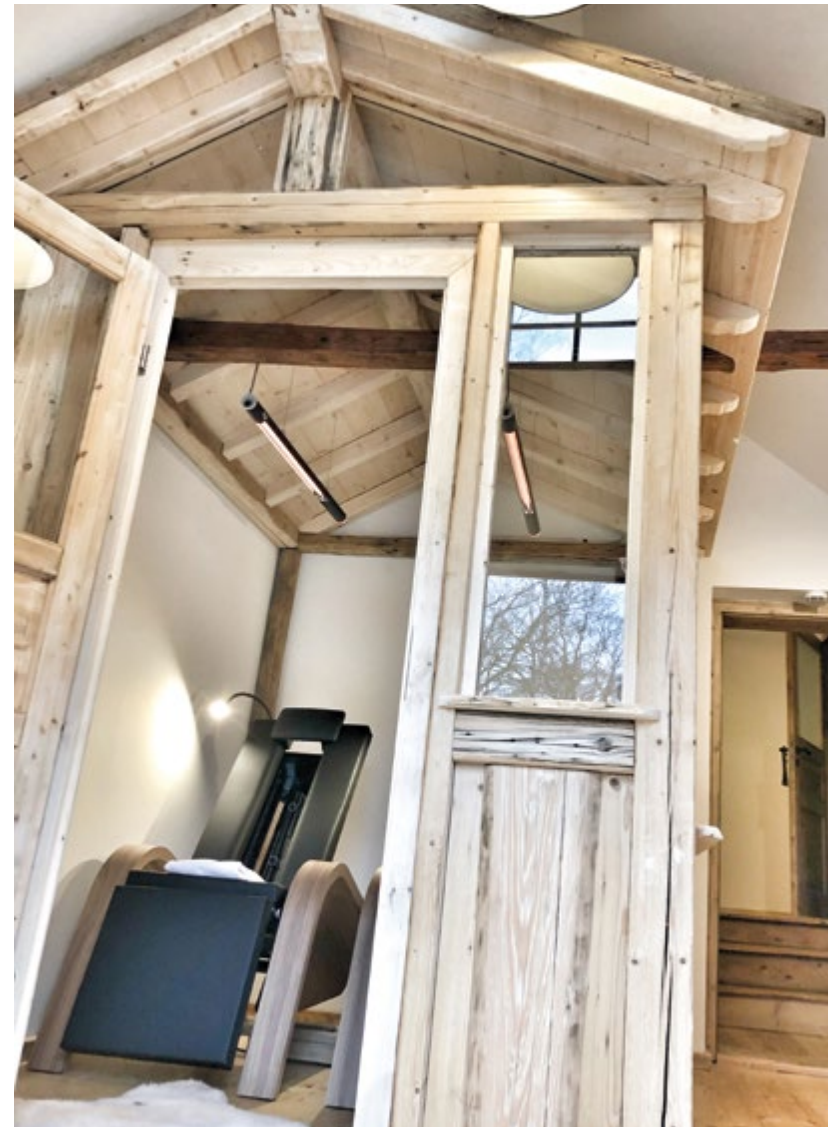
HeatTube – Berghütte Vogtland*****, DE
